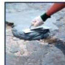
SISTEME EPOXIDICE PENTRU REPARAȚII
