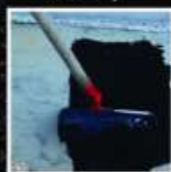
HIDROIZOLARE FUNDAȚII
